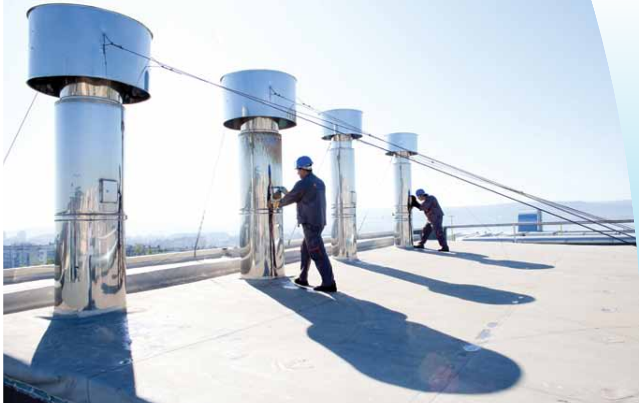
Prace remontowe w obiekcie handlowym
